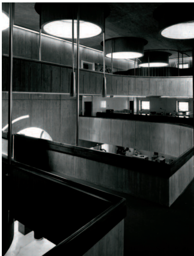
Fig. 7 - Palazzo Mosconi, Verona. Veduta delle passerelle aree del primo piano con gli oculi aperti nel soffitto che producono, sulle superfici, riflettenti in marmo di Lasa e assorbenti in calcestruzzo, articolati effetti plastici e luministici (BOGONI, 2009).
