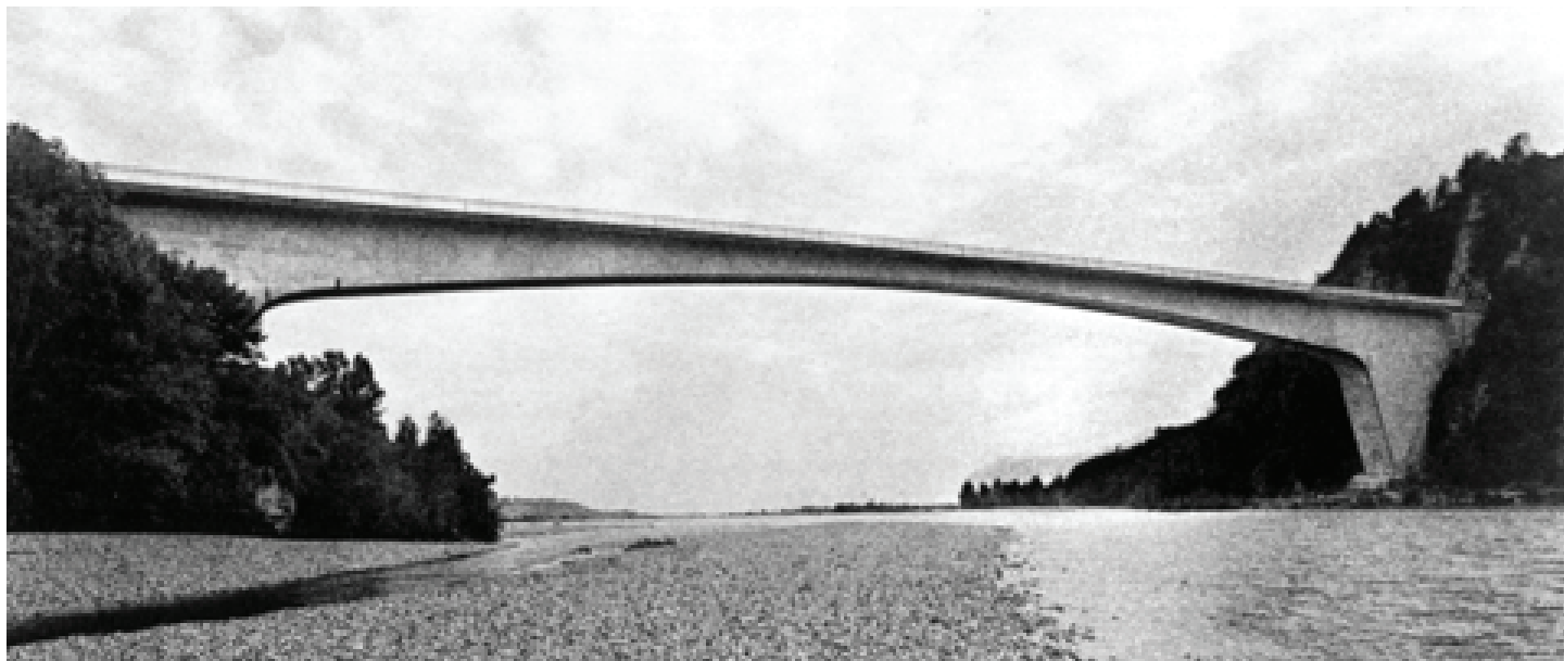
Ponte sul fiume Tagliamento a Pinzano, 1968-69 (luce 163 m)
