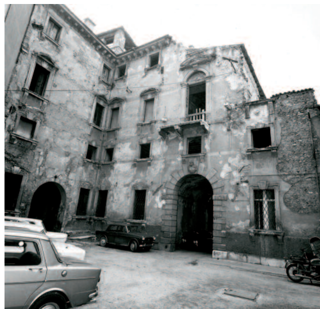
Fig. 2 - Palazzo Mosconi, Verona. Stato di conservazione al 1966: l'ala nord del palazzo e l'edificio medievale innalzato sulle mura romane furono completamente distrutti dai bombardamenti della Seconda Guerra Mondiale; altre parti del complesso versavano in forte stato di degrado (BOGONI, 2009).
