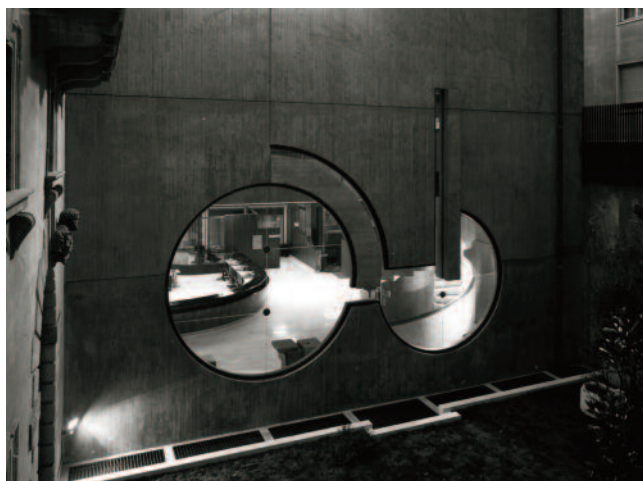
Fig. 5 - Palazzo Mosconi, Verona. Fronte verso la corte interna: il diaframma leggero del cemento faccia a vista consentì una grande libertà compositiva e contribuì a realizzare una fluida continuità spaziale tra interno ed esterno (BOGONI, 2009).
